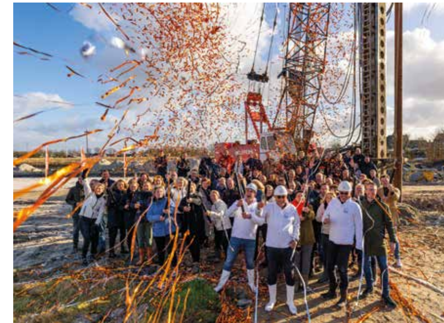
De eerste palen van het nieuwe duurzame Nh1816-pand zijn geslagen
